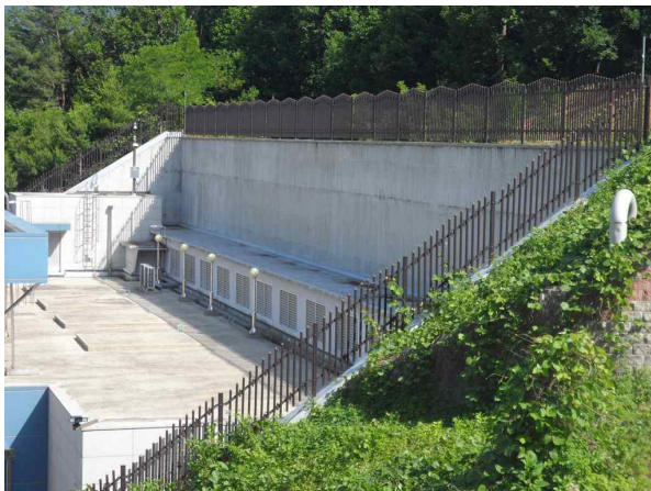
옹벽 상단 전경
